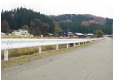
ガードレール
