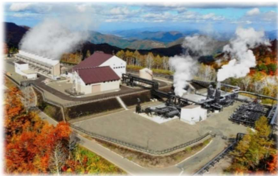
山葵沢地熱発電所
