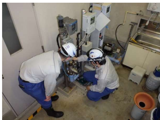
計装設備点検状況
