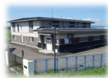
湯沢地区上水道 岩崎浄水場
