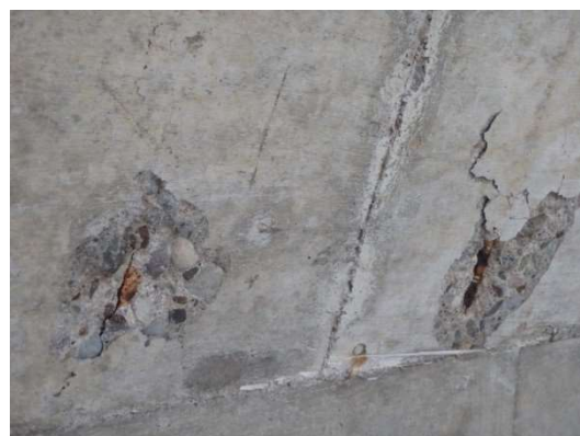
床版剥離・鉄筋露出
