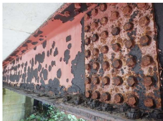
主桁の腐食
