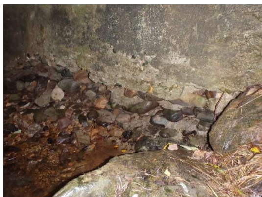
橋台に著しい洗堀
