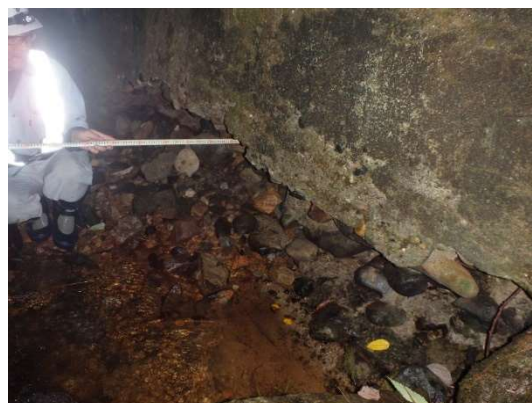
橋台に著しい洗堀
