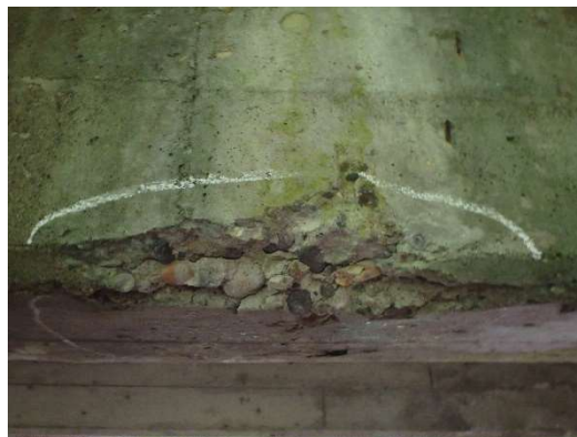
剥離、鉄筋露出
