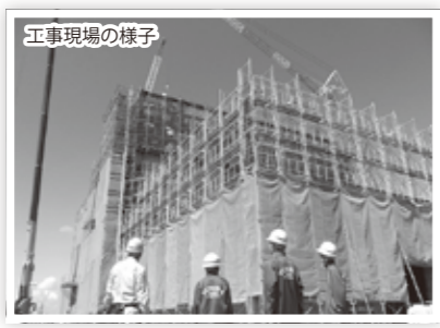
工事現場の様子
