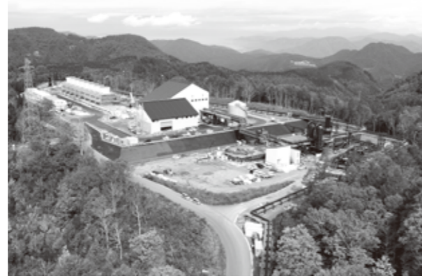
▼山葵沢地熱発電所
