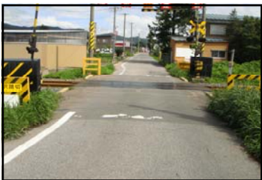
㉒ 旧商工入口からの杉沢踏切
