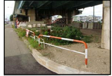
②⑦ R 3 9 8 跨線橋下の道路
