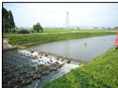
③⑫ 上八幡 白子川堰堤・水門
