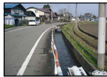
⑨八幡の道路沿い水路
