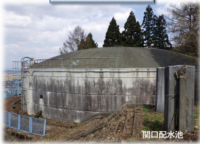
関口配水池の更新
