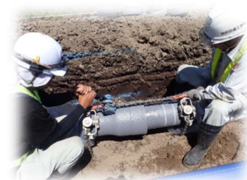
ダクタイル鋳鉄管 施工状況
