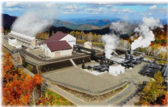
山葵沢地熱発電所
