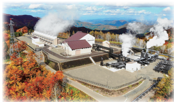
山葵沢地熱発電所
