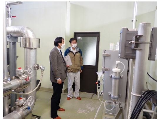
湯沢市公営企業アドバイザー 水道施設現地視察 (令和4年11月実施)
