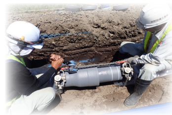
ダクタイル鋳鉄管 施工状況
