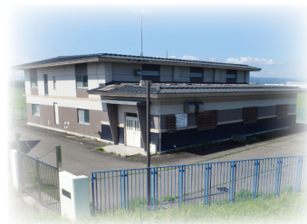
湯沢地区上水道 岩崎浄水場
