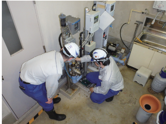
計装設備点検状況
