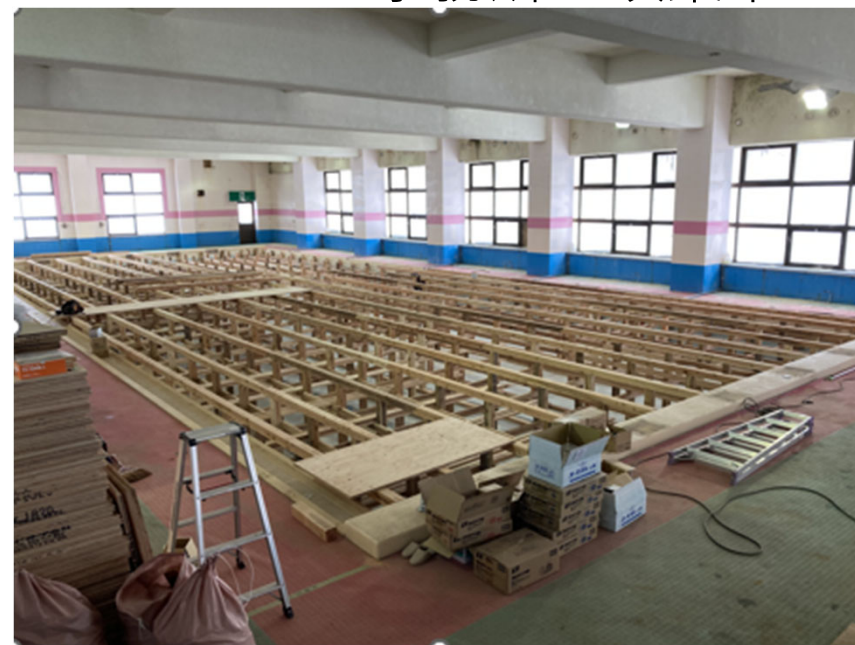
2023年2月10日現在 プールを事務所に改築中
