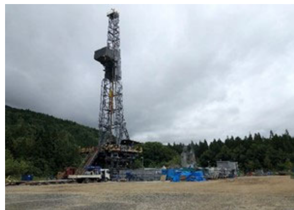
掘削時の様子
