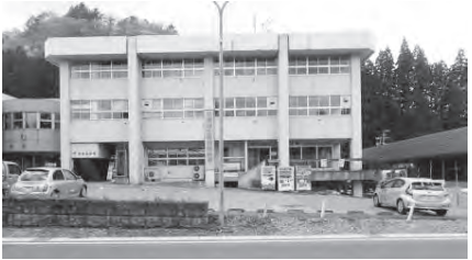
解体される皆瀬開発総合センター
