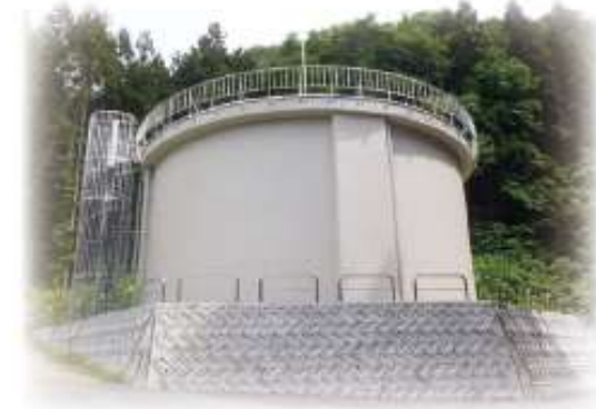
配水池の改修例
