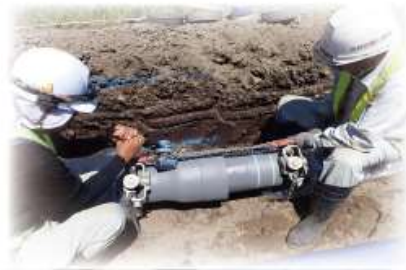
耐震管の布設工事例
