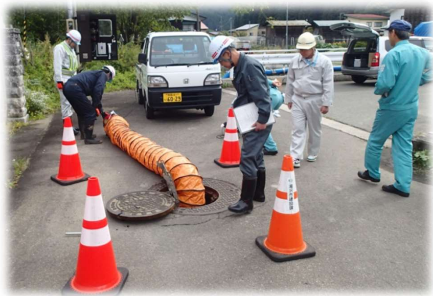
マンホールへのガス検知器と送風機の 使用手順訓練の様子
