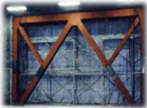
鉄骨ブレースの設置 【中継ポンプ場の開口部等】
