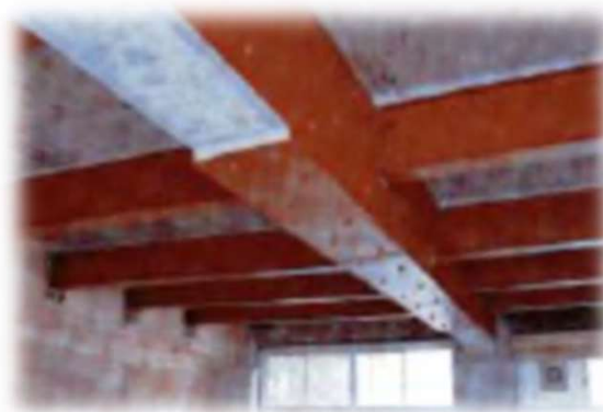
炭素繊維鉄鋼巻き補強 【建物天井の梁部】
