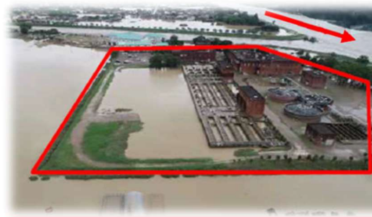
九州地方下水道施設の被害状況
