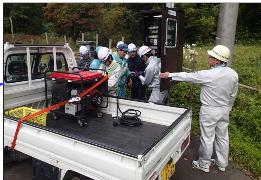
マンホールポンプ場 非常用電源接続訓練の様子
