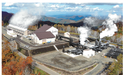
山葵沢地熱発電所
