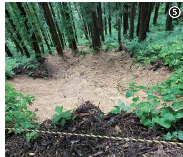
⑤【稲川地域】稲庭城遊歩道(法面崩落)
