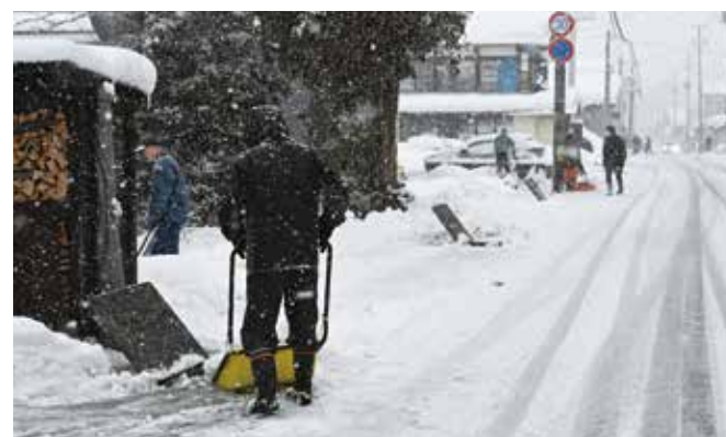
湯沢大堰の水を活用した流雪溝。ポンプを使うなどし、水を流す時間が決められている。
