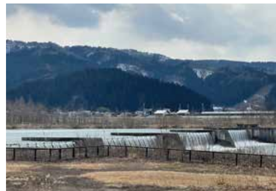
雄物川に設置された湯沢統合堰。ここから取水された水が湯沢大堰に送られる。
