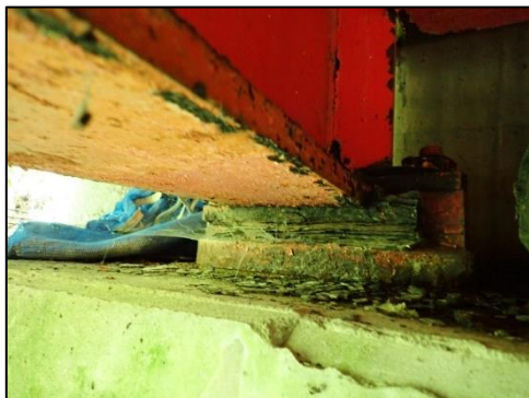
写真2 皿小屋線 1 号橋
