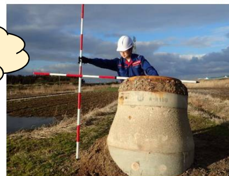
マンホール浮上現場（中能登町）
