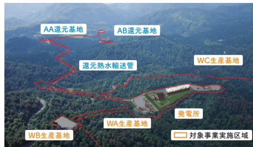
山葵沢地熱発電所
