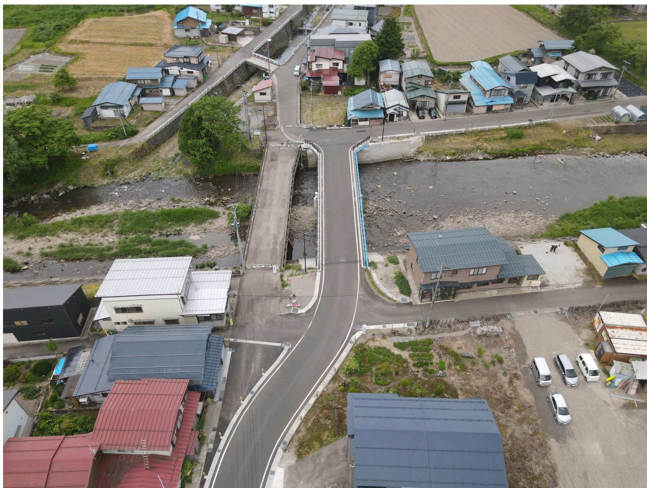
市道横川・町後線 常盤橋
