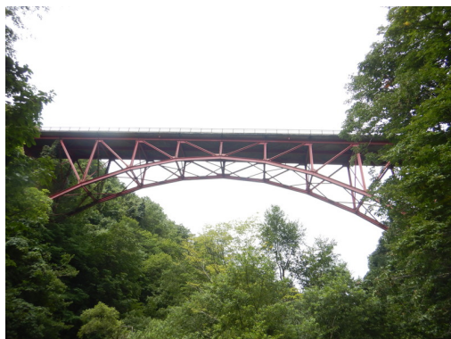
赤倉橋(アーチ橋 橋長115.0m)
