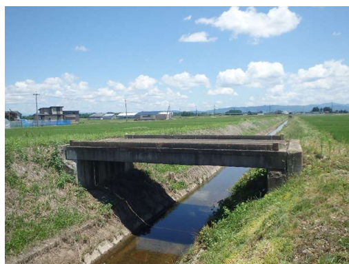
岩崎弁天排水路1号橋(RC橋 橋長6.1m)
