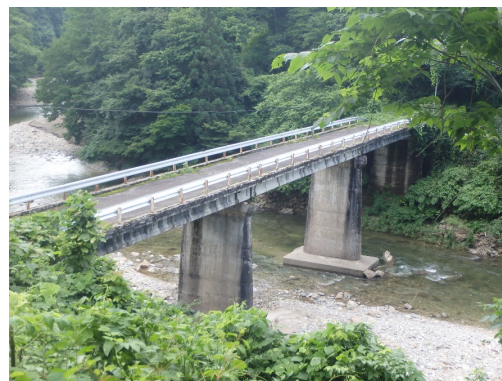
滝ノ原橋(PC橋 橋長51.5m)
