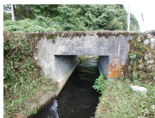
大沢1号橋(溝橋 橋長2.8m)
