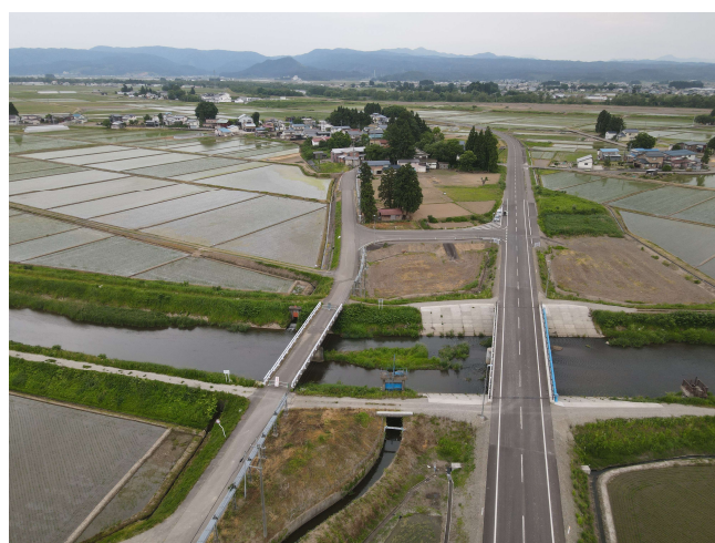
写真-2 集約化・撤去橋梁(白子川橋)
