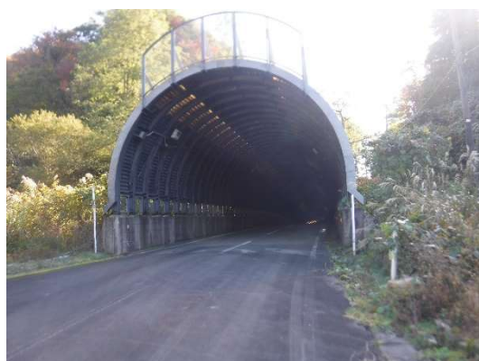
宇留院内峠スノーシェルター
