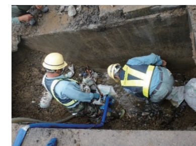
水道工事の様子
