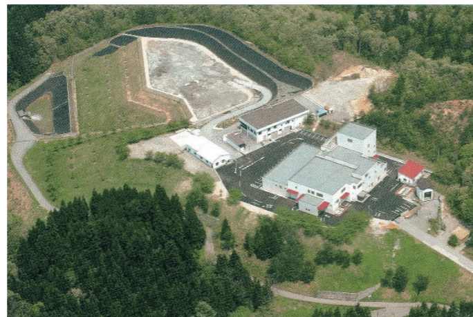
湯沢雄勝リサイクルセンター
