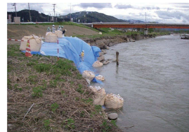
堤防補修工事の様子
