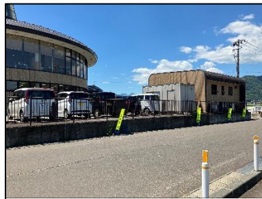
道の駅と農産物直売所との管理用道路及び擁壁
