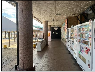
休憩施設棟前面の通路
