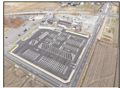
西側駐車場（新設）
