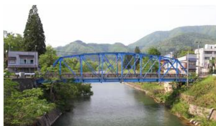
「菅生橋」 県指定有形文化財（建造物）
