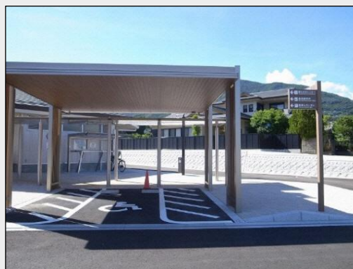
屋根のある車いす使用者用駐車場
