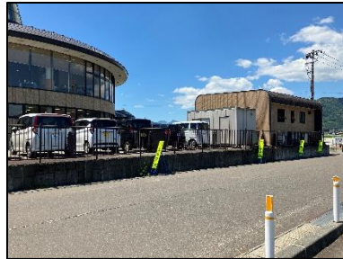
道の駅と農産物直売所間の管理用道路及び擁壁
