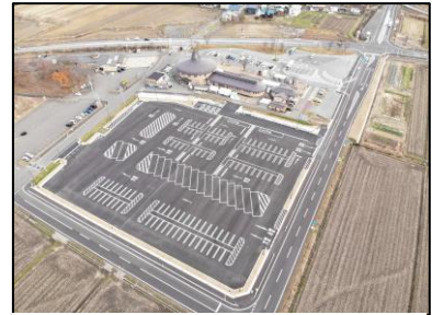
西側駐車場（新設）
