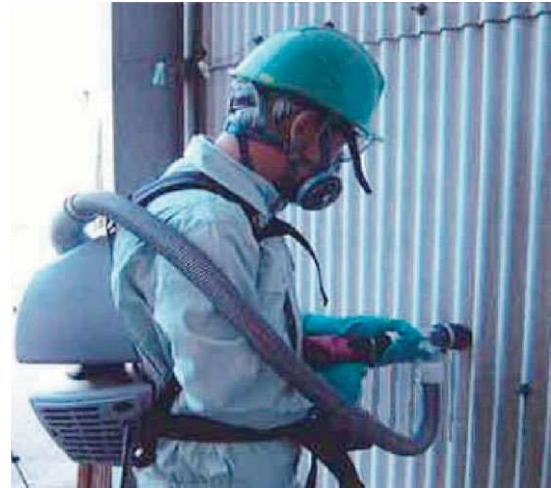
図 3. 111 機械工具による切断例
