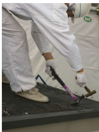
接合固定部分の取外し
