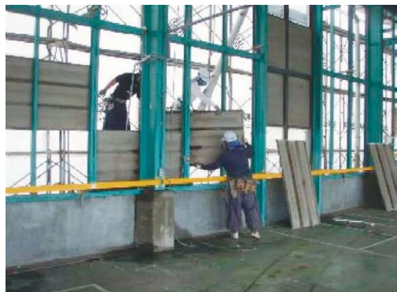
壁石棉含有成形板取外し
