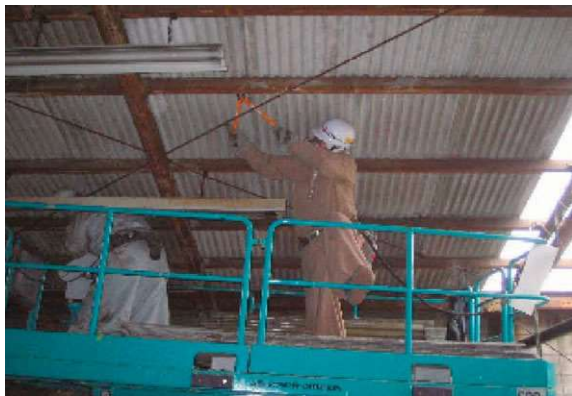
屋根スレート止め金物切断
