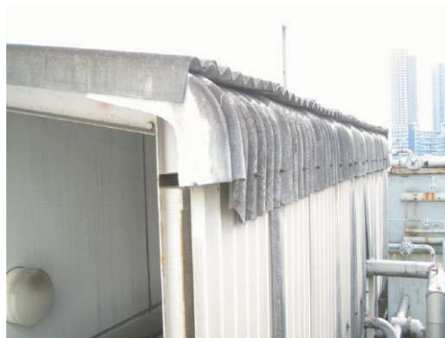
図 3. 105 石綿含有スレート波板
