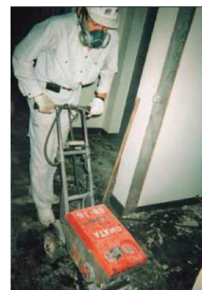
図 3. 114 石綿含有ビニルタイルの除去例
