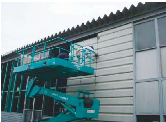
壁金物取外し
