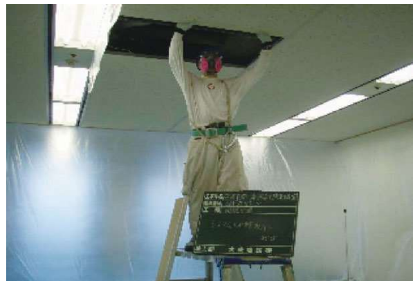
図 3.110 天井石綿含有成形板の除去例
