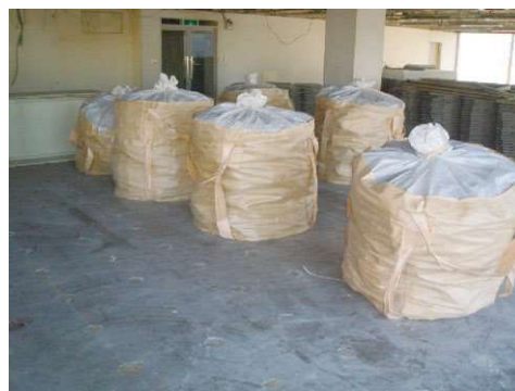
図 3. 116 石綿含有成形板廃棄物の保管例
