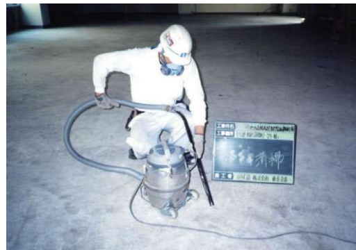
図 3. 115 清掃 高性能真空掃除機使用例
