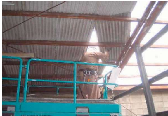
屋根スレート取外
