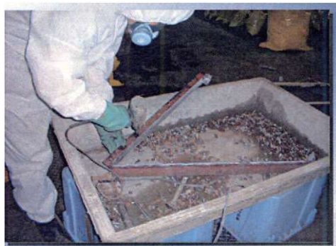
図 3. 118 掻き落とし除去作業の例
