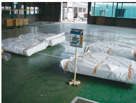
図 3. 116 石綿含有成形板廃棄物の保管例
