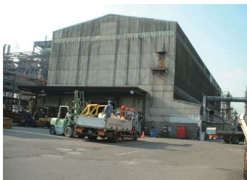
図 3. 105 石綿含有スレート波板
