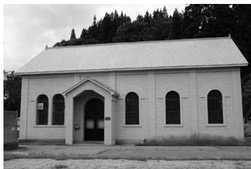
▲樺山発電所本館
