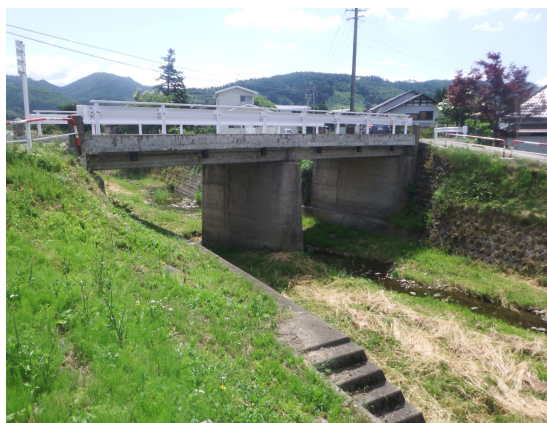
東福寺橋（RC橋 橋長16.0m）
