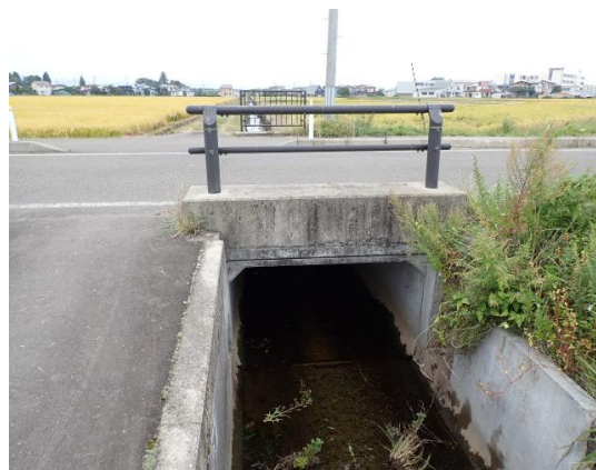
沖田1号橋（溝橋 橋長2.1m）
