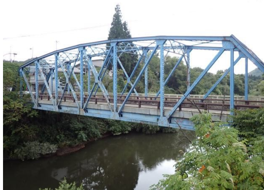
菅生橋（トラス橋 橋長43.7m）
