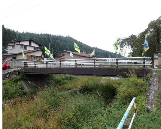
新五月町橋（PC橋 橋長18.0m）
