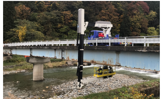
橋梁点検車による点検状況
