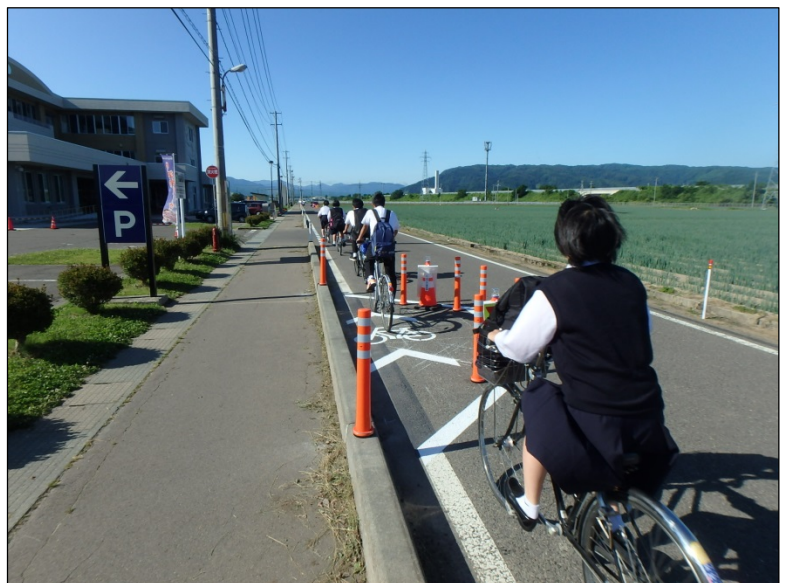
《対策後通学状況写真》
