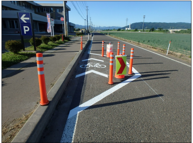
《対策設置完成写真》
