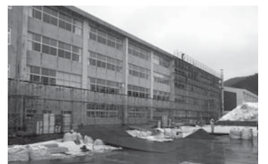
▲湯沢南中学校工事の様子
