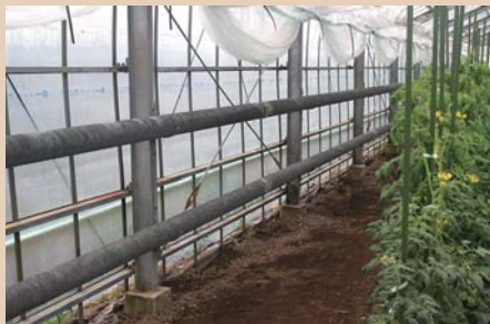
(上) 約70度の地熱水を循環させる管。冬でもハウス内を15度前後に保ちます。
