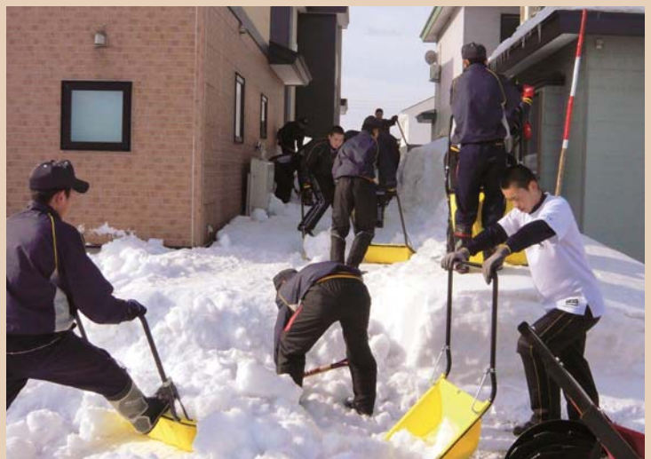
昨年の活動の様子。屋根から滑り落ちた雪は一階の屋根まで積もり、硬く締まっています。対象世帯の生活圏を確保するため、積もった雪を崩しながら排雪し、出入口や避難口、窓の周辺、プロパンガスボンベの周辺、ストーブの排気口などを確保します。
