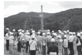
▲生産井を掘削しています
