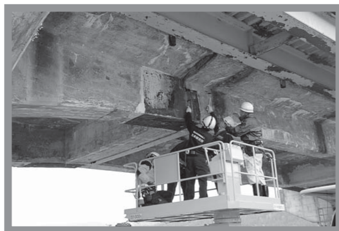
▲高所作業車で触診し点検する技術者
