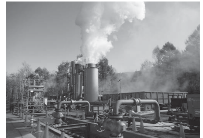
▲噴気試験（山葵沢地熱発電所）
