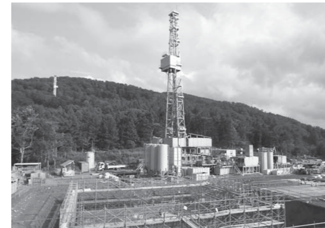
▲生産基地用水ピット工事（山葵沢地熱発電所）
