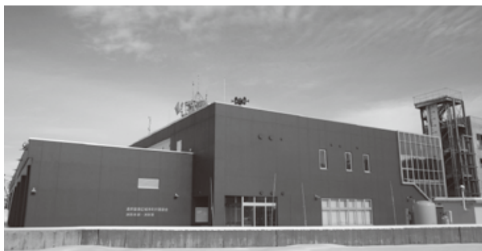
▲南側から見た新消防庁舎
