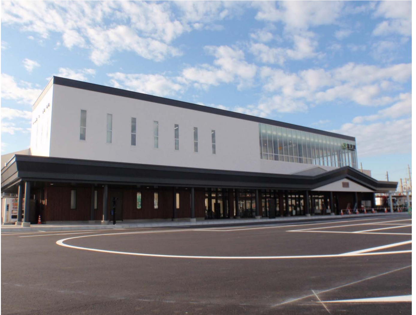
湯沢駅新駅舎
