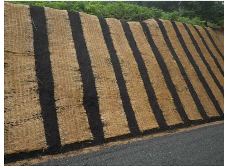
植生基材吹付(菰張り)
