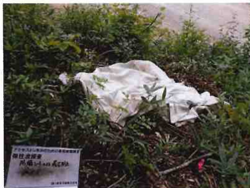
⑦発破点に防爆シートを設置して飛び石防止策
