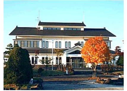
湯沢浄化センター
