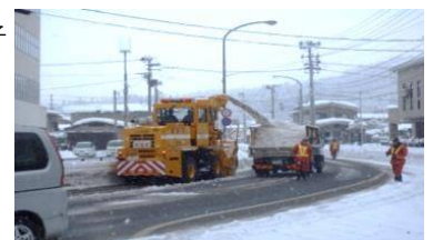
除排雪作業の様子
