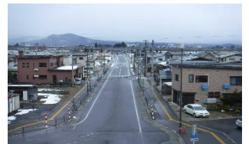
令和元年12月に供用を開始した 駅西線道路(湯沢駅西口)
