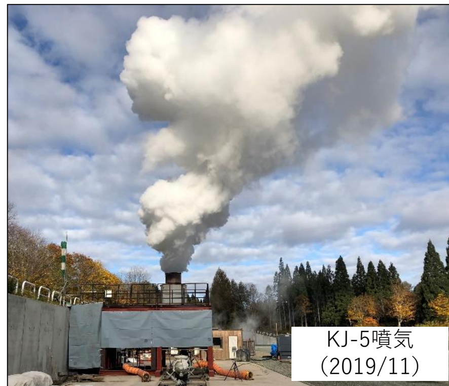
短期噴気試験にて蒸気を確認
