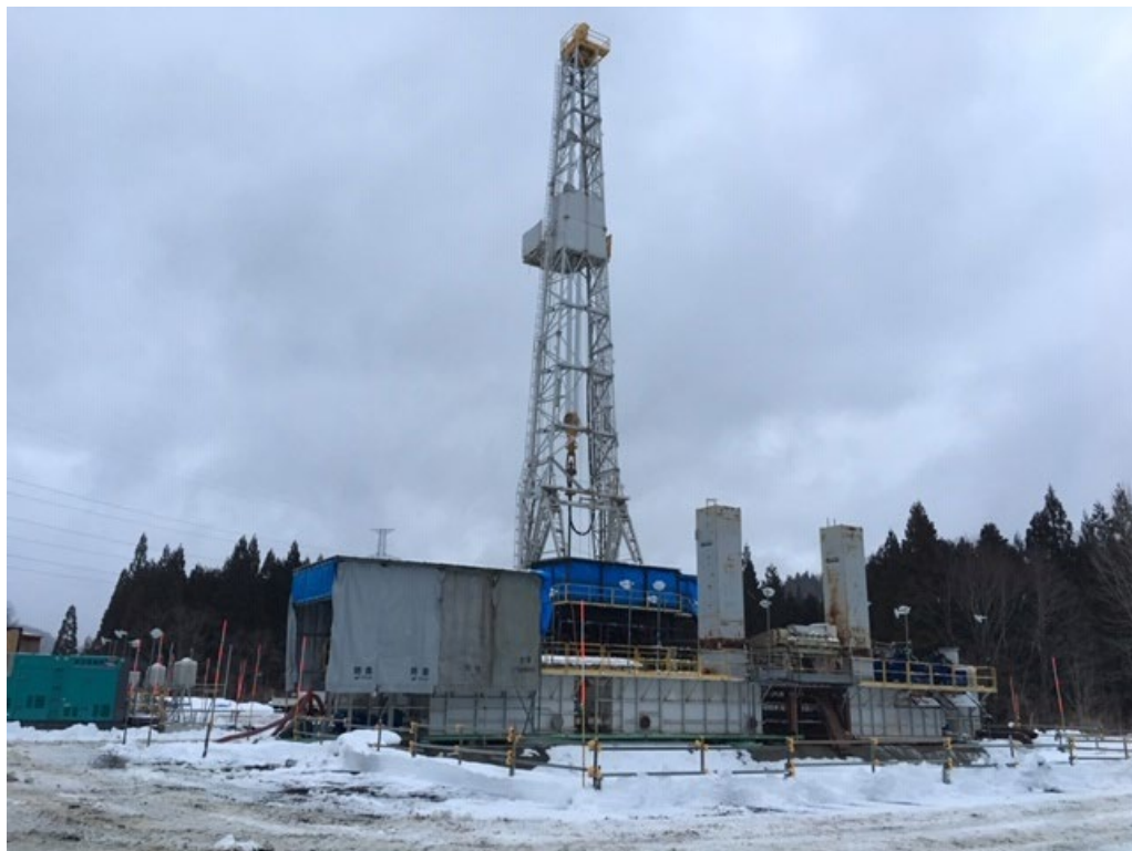
掘削現場の様子
