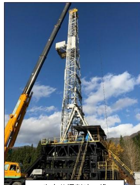
生産井掘削時の櫓
