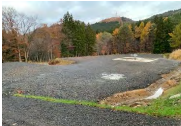
掘削完了後の敷地
