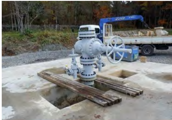
掘削完了後の井戸元
