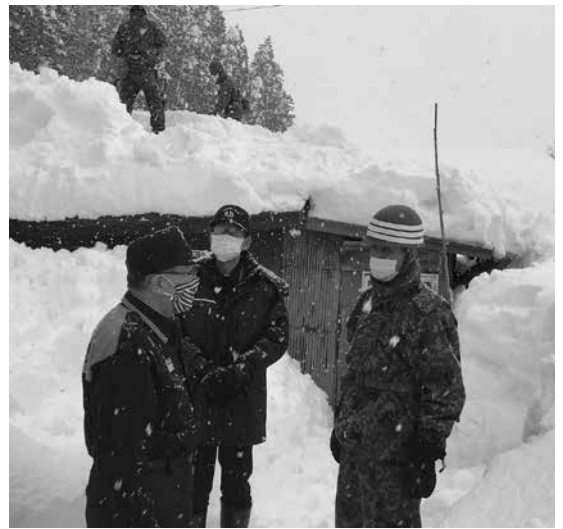
▲自衛隊との現場状況確認
