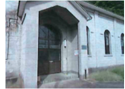
No. 2 樺山発電所
