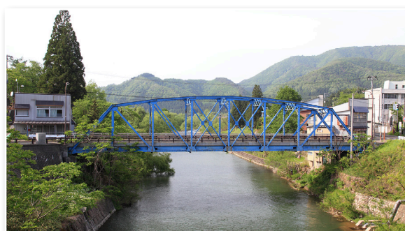
「菅生橋」県指定有形文化財(建造物)
