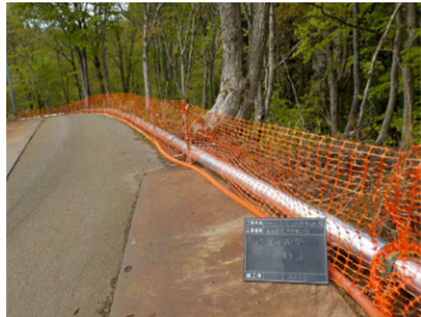
噴気試験時の仮設還元パイプライン
