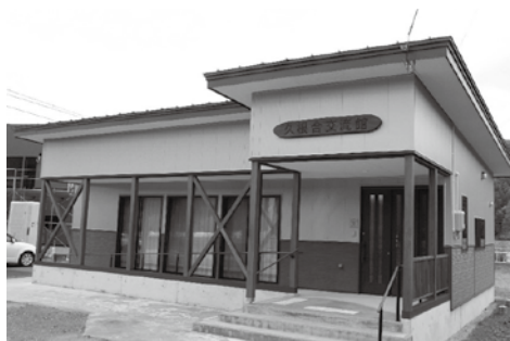
▲久根合自治会が新築した自治会館
